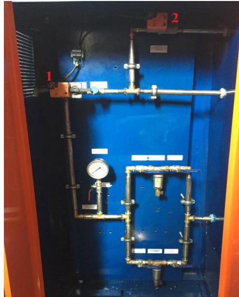
Հիդրավիկ ղեկավարման համակարգի վահան Նկար 2
